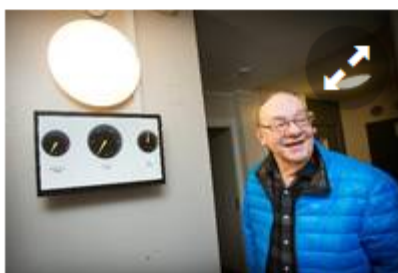
I trapphuset kan Torbjörn Malmeström och de andra medlemmarna i bostadsrättsföreningen se hur mycket el de 277 solcellspanelerna producerar just nu.
