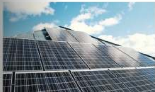
273 solpaneler ska generera cirka 80 ampere el.
